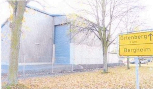
Am Ortsausgang Richtung Ortenberg steht die imposante Stahlhalle der Bergheimer Heizzentrale. Fotos: Dörschner
