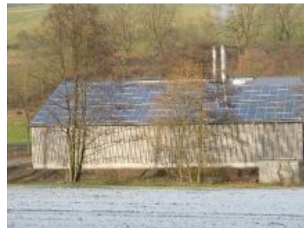
Die Solarzellen auf dem Dach des Bergheimer Heizkraftwerkes erzeugen nicht nur den Strom für den Eigenbedarf. Er wird auch ins Netz eingespeist. Foto: Wohlfahrt
